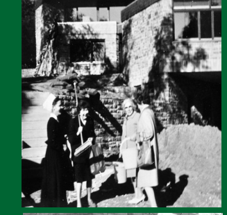
Das Foto zeigt Frauen aus der Frauenhilfe mit Schwester Hildegard an der Baustelle.
